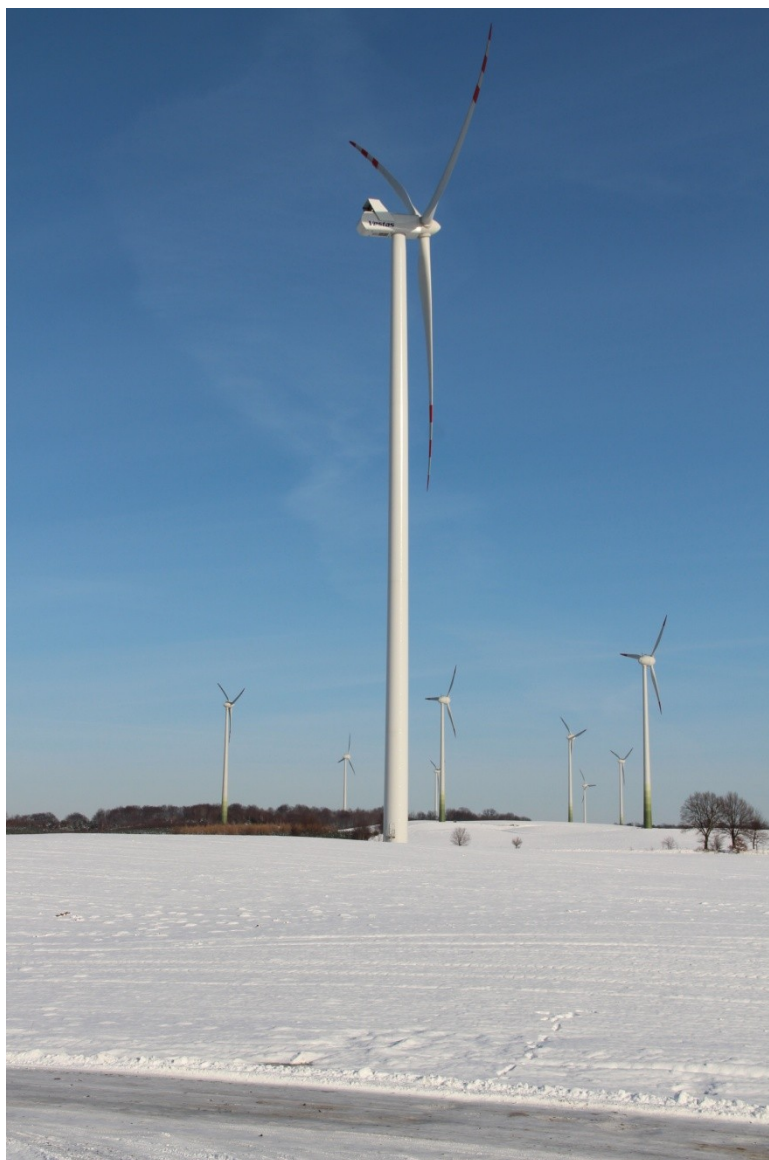
Rys. 1 Elektrownia wiatrowa typu Vestas V90 – 2 MW, w tle elektrownie firmy Enercon (Lisewo, gm. Gniewino)
